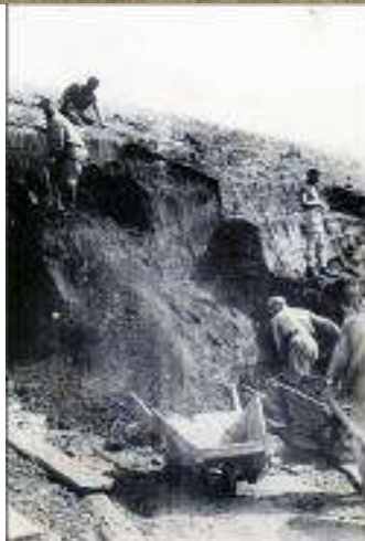
Отсыпка насыпи железнодорожного полотна тачками.
