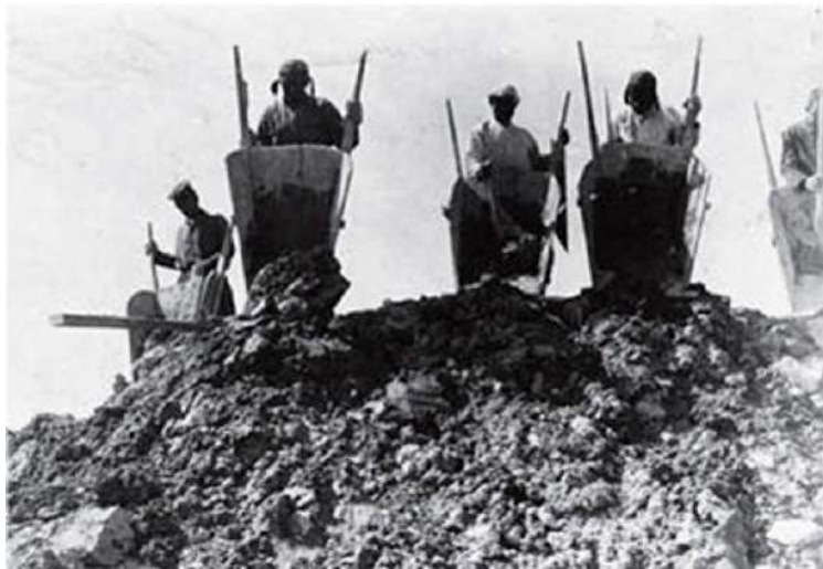
На строительстве Волжской рокады 1942г.
