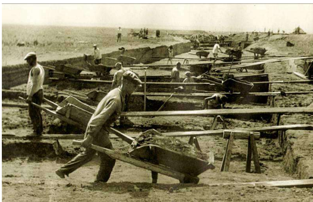
Отсыпка насыпи железнодорожного полотна тачками.
