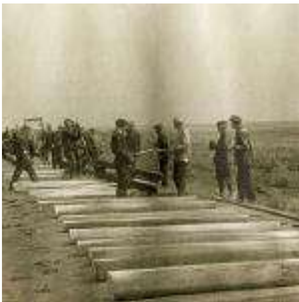
На строительстве Волжской рокады 1942г.
