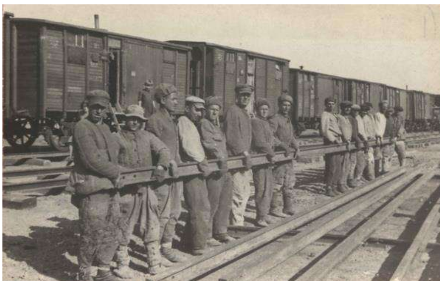
Строительство Волжской рокады 1942 год
